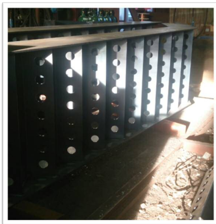
左の踏み板を組立したところです。 ササラ PL-12 1枚もので切断しています。
